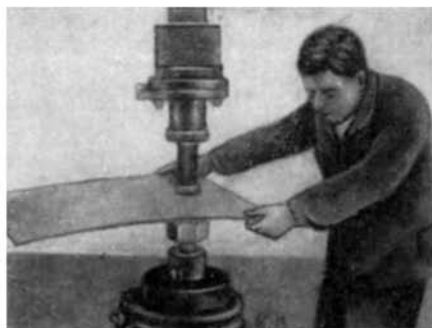
Рис. 25. Правка на пневматическом молоте
