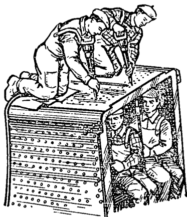
Рис. 115. Клепка пневматическими клепальными молотками корпуса котла
