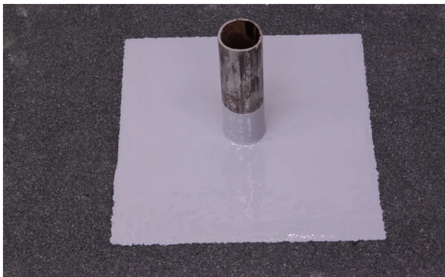
Рисунок 9 – Выполнение примыкания водоизоляционного слоя покрытия к холодным трубам из материалов, к которым у мастики имеется адгезия
