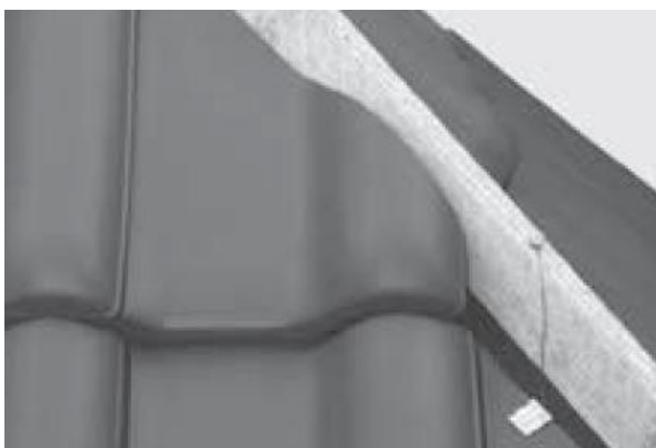
Рисунок 16 – установка черепицы на хребте
