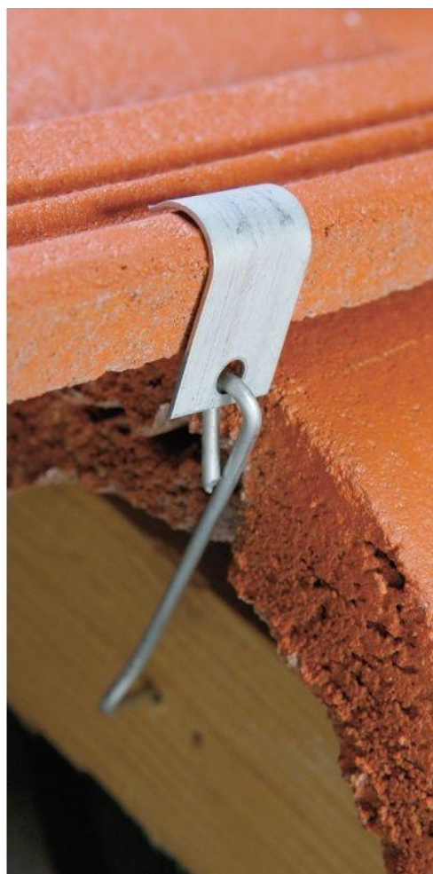
Рисунок 8 – Установка противовеетрового зажима (пример)
